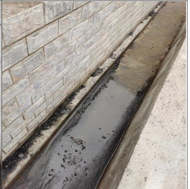
厂区雨水排水沟
