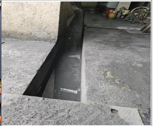
主洗车间排水沟
