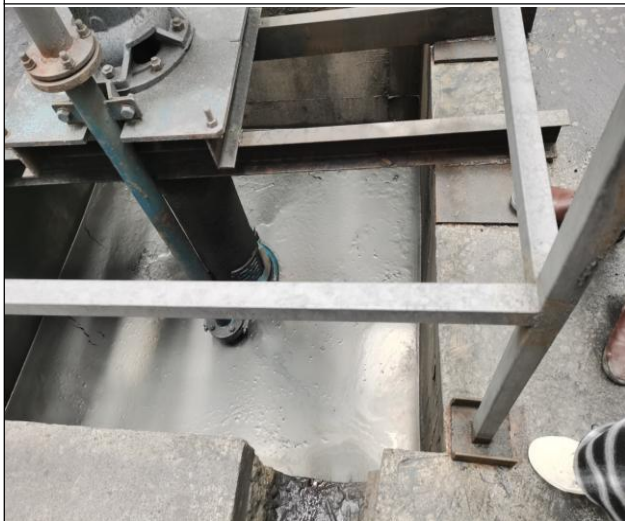
主洗车间循环水池
