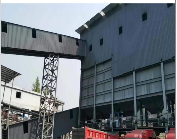
封闭皮带运输
