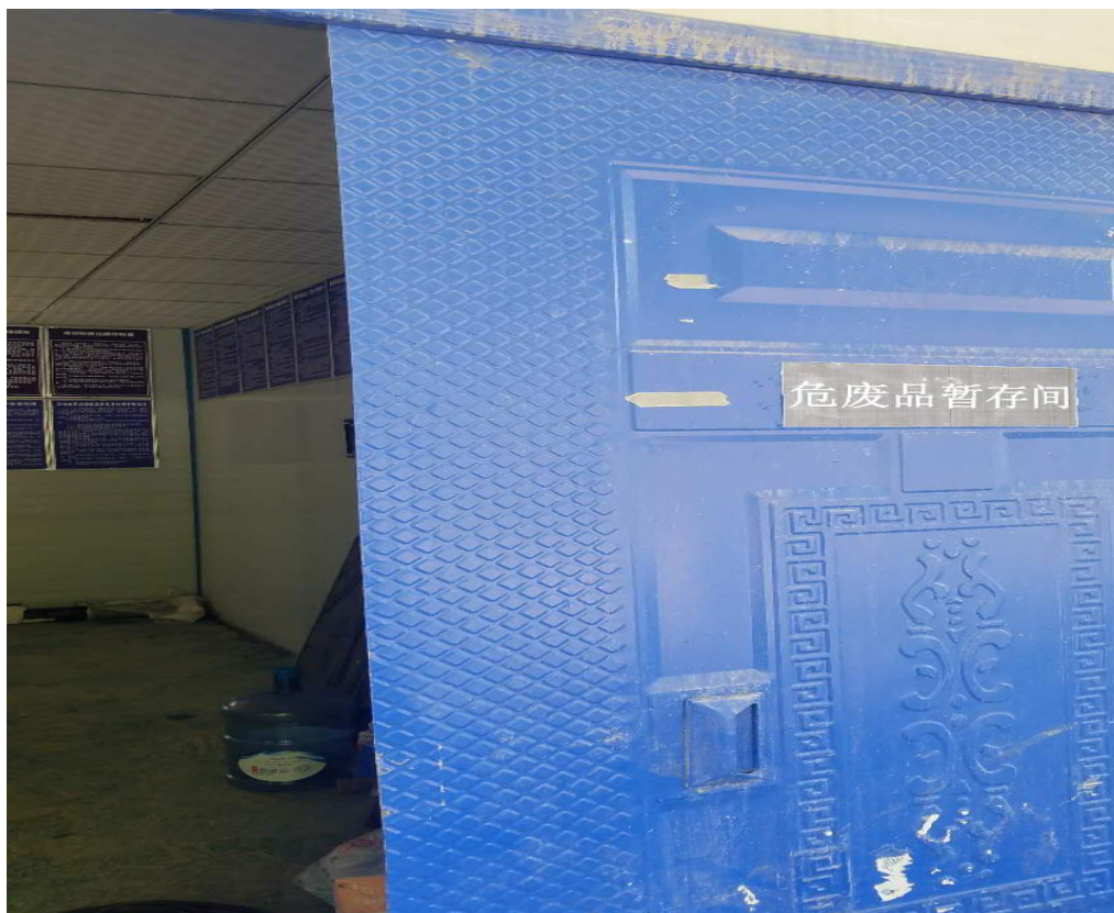
图 5-3 项目危废暂存间
