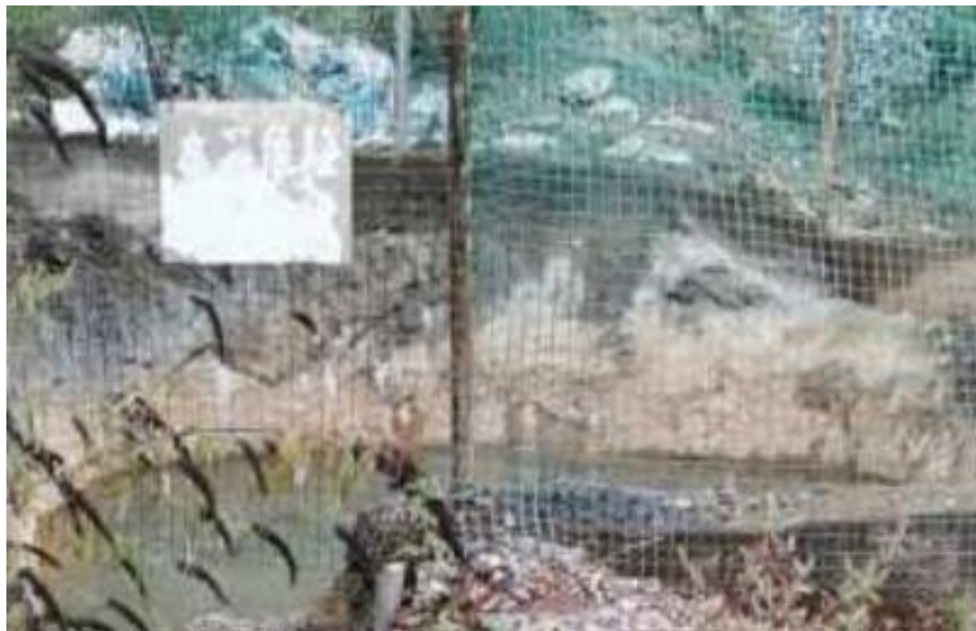
图 5-4 项目雨水沉淀池
