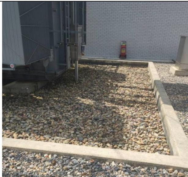
110KV变电站变压油防渗底槽
