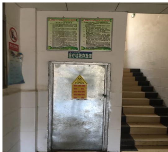
图 5.1-2 医疗废物暂存间图
