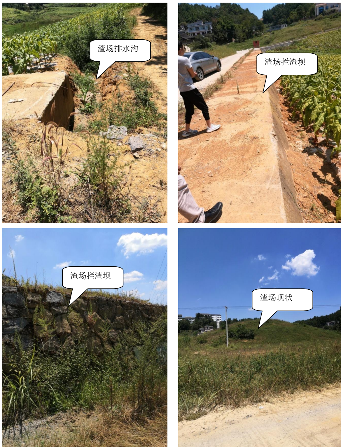
弃土（渣）场现场情况图
