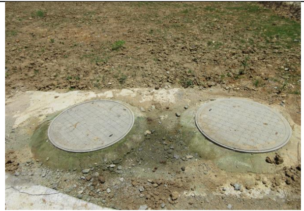
生产工艺含油废水隔油沉淀池
